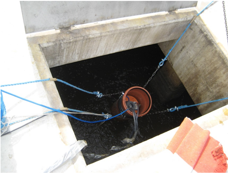
Abbildung 15. Kleinere Ablufthaube für die Messung in abgedeckten Belebungsbecken
