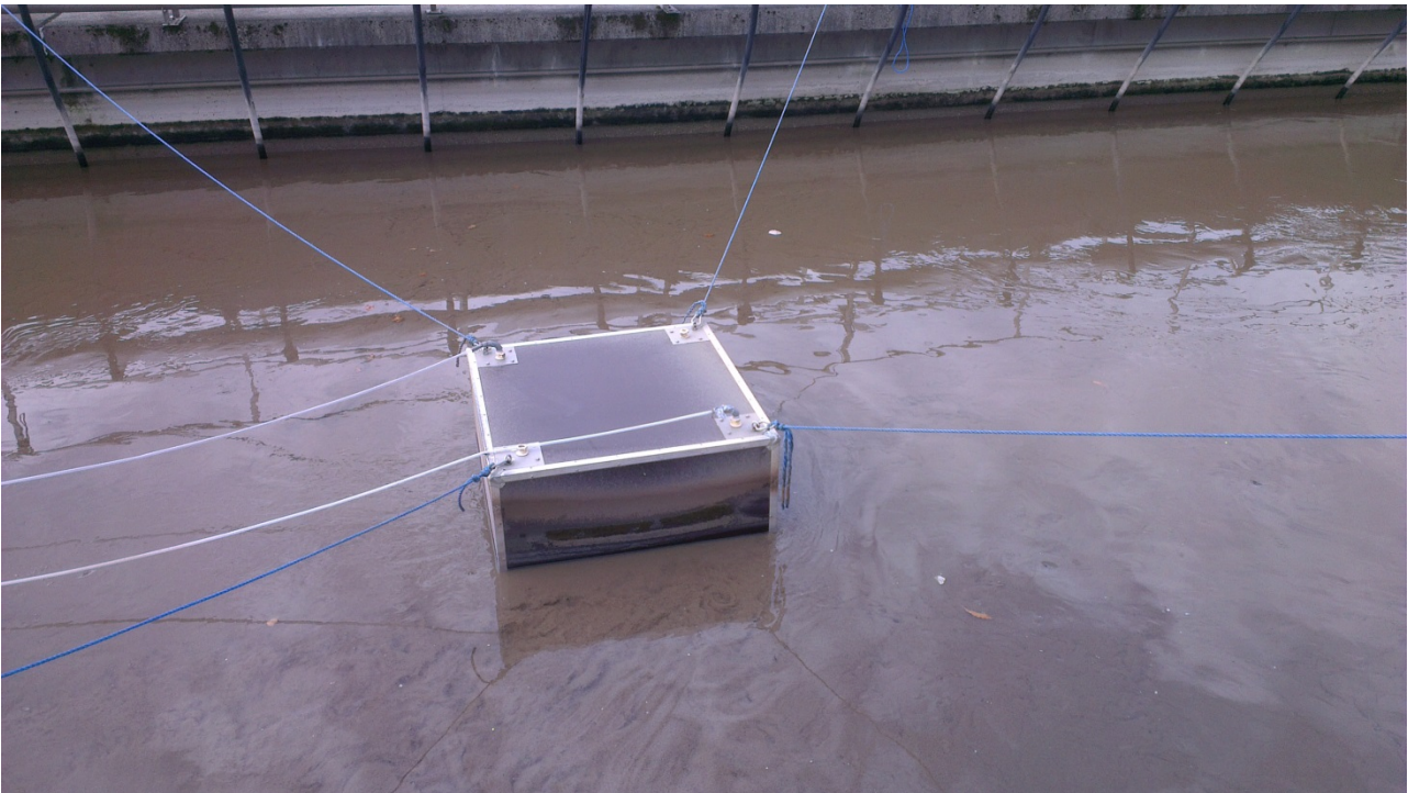
Abbildung 11. Ablufthaube während einer Messung in einem Belebungsbecken.
